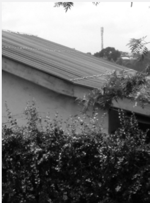
Nowy dach w Cheleta Primary
