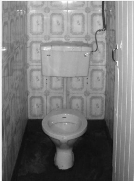
Wyremontowana toaleta w Highridge
